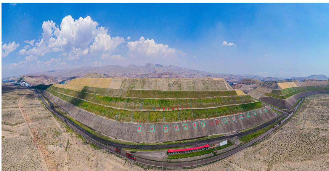
东外排土场位于采区东侧，占地面积  $0.2174 \text{ km}^2$ ，分 7 个台阶排弃，台阶高度为 20 米，边坡坡面角在  $33^\circ$  左右，排土场高度为 93 米，具体情况详见下图。
